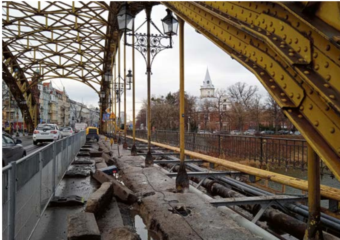
Trwa remont od Wybrz. Pasteura. Piesi i rowerzyści mogą poruszać się drugą stroną przeprawy
