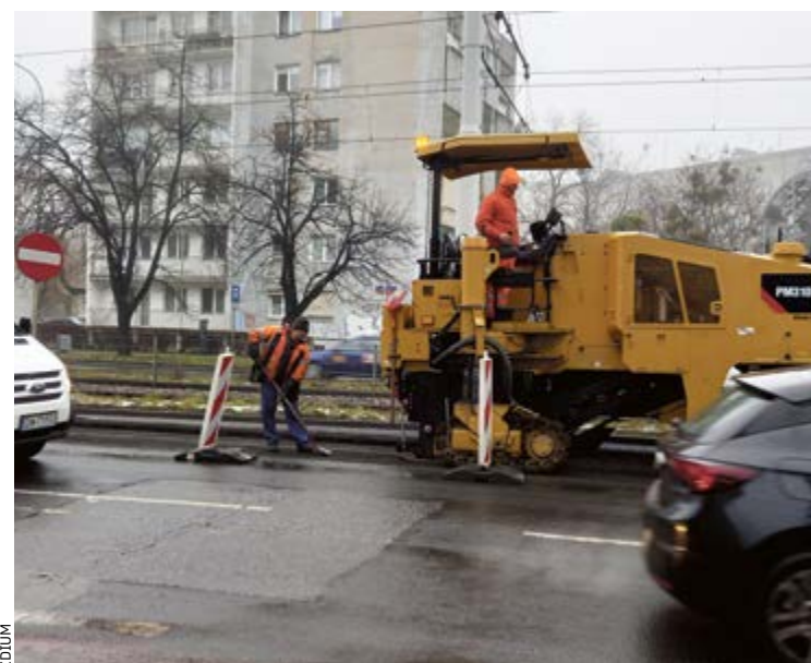
Prace obejmują ułożenie nowych warstw betonu asfaltowego
